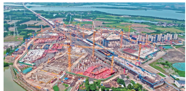
苏州南站站房主体工程开工典礼
