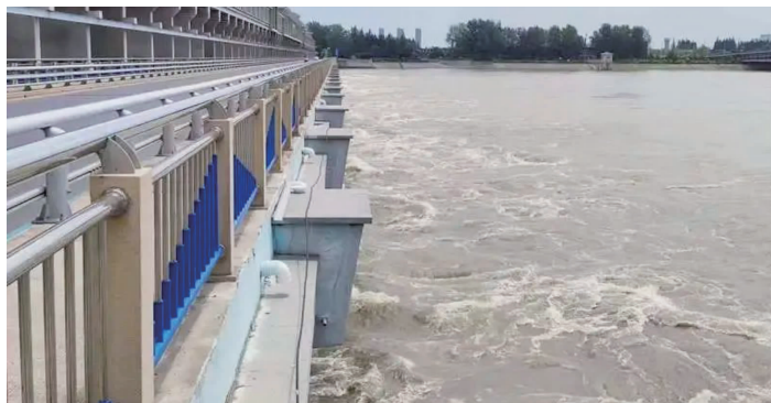
近日,扬州及里下河地区出现强降雨,河湖水位快速上涨,江都水利枢纽4座泵站33站机组全部投入排涝运行 通讯员供图
