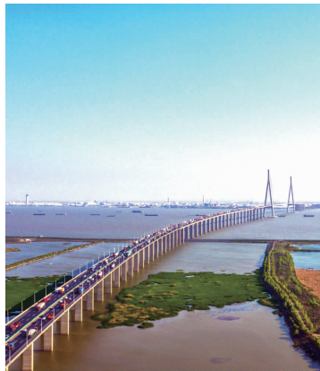
苏通大桥 苏锡通科技产业园区供图
