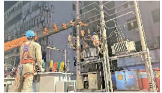
工作人员对变压器进行增容改造 通讯员供图
