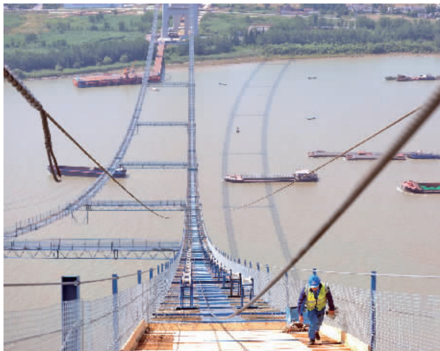
龙潭长江大桥空中施工通道全线贯通 现代快报+记者 顾炜 摄
