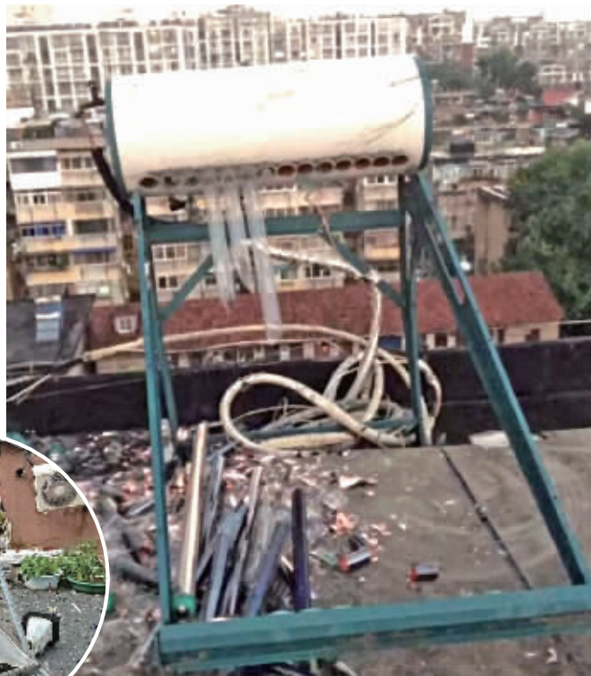
楼顶摇摇欲坠的太阳能热水器 受访者供图
