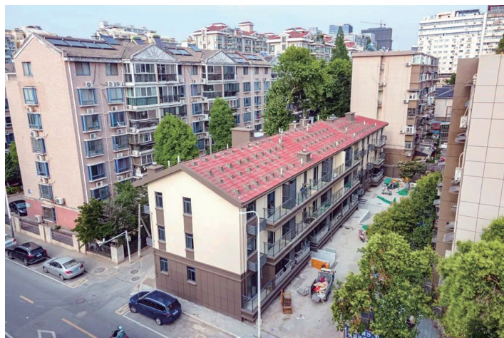
大阳沟更新项目 南京市建委供图
