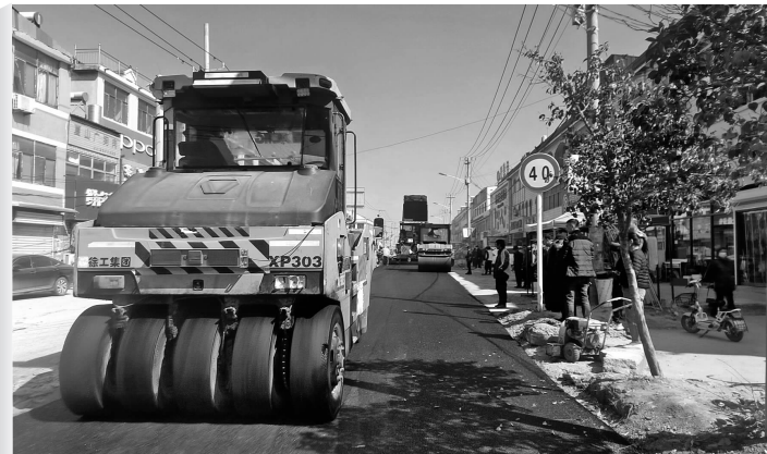
维修后的路面正在铺设沥青 通讯员供图
