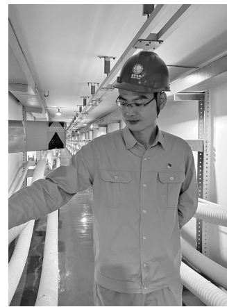
段庆权在检修线路
