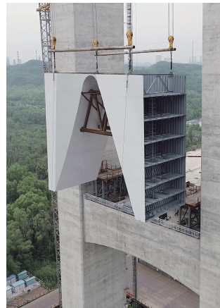
施工现场 通讯员供图
