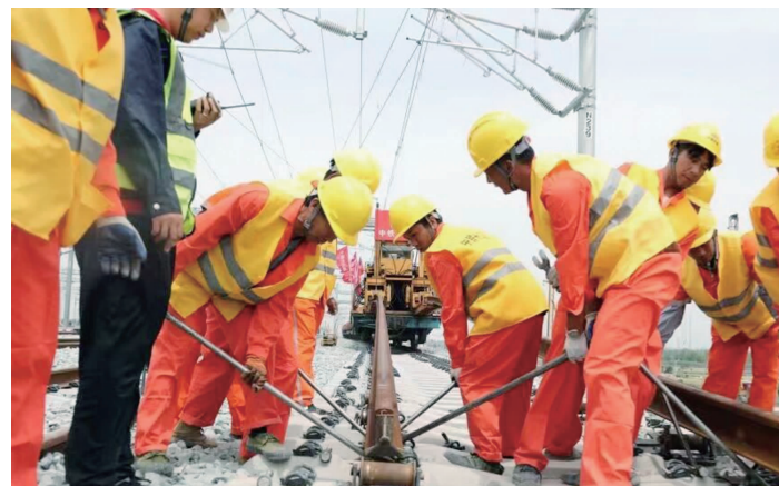
▲沪宁沿江高铁太仓站,工人铺设最后一组钢轨 通讯员 潘林 摄
