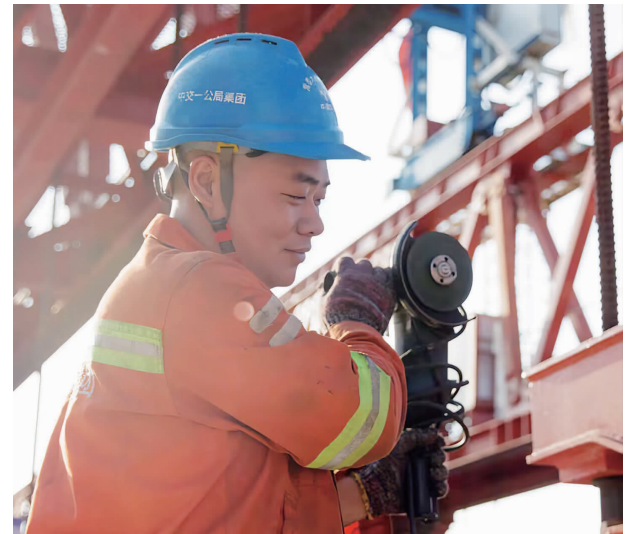
施工人员在神贯注地工作 通讯员供图
