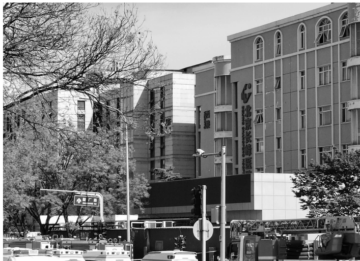
4月18日拍摄的北京长峰医院救援现场 新华社记者 张晨霖 摄
