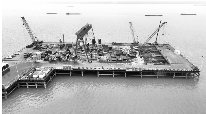
张靖皋长江大桥南主塔桩基施工完成 中交二航局供图
