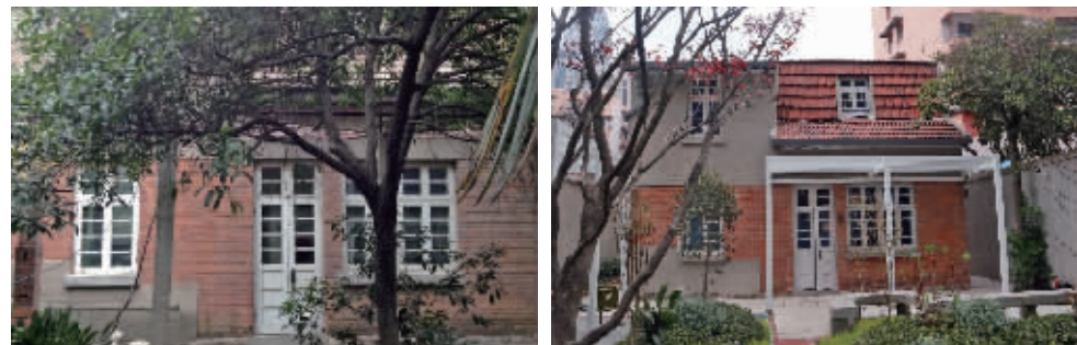
老宅南立面修缮前(左,图片由南京历保集团提供)后(右)对比
