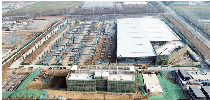
格雷博电驱动总成项目工地 通讯员供图
