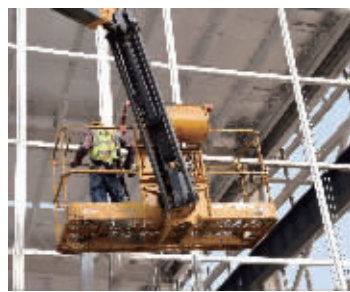
联博新能源汽车驱动电机定子项目建设现场 范昀 摄
