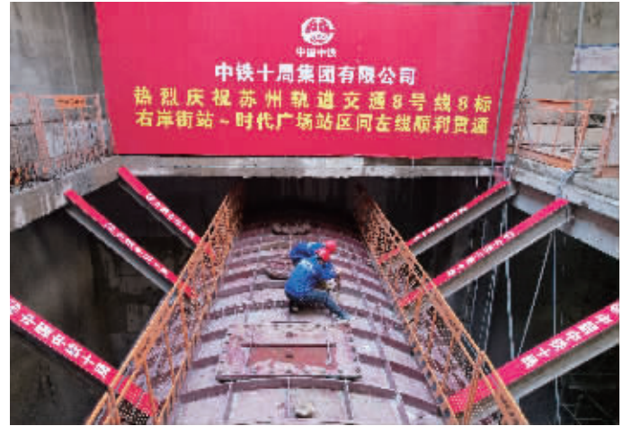
3月6日,苏州轨道交通8号线8标盾构施工取得重大突破:中铁十局城轨公司“圆融3号”盾构机在磨桩穿越圆融桥和亚洲最长独特视觉构筑物——圆融天幕,顺利磨墙穿越运营地铁1号线,安全抵达时代广场站区间左线顺利贯通,为国内同类型盾构施工积累了核心技术经验。 高达/文 王传武/摄
