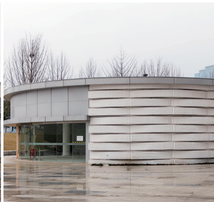
江北新区市民中心接待中心也用了3D打印技术
