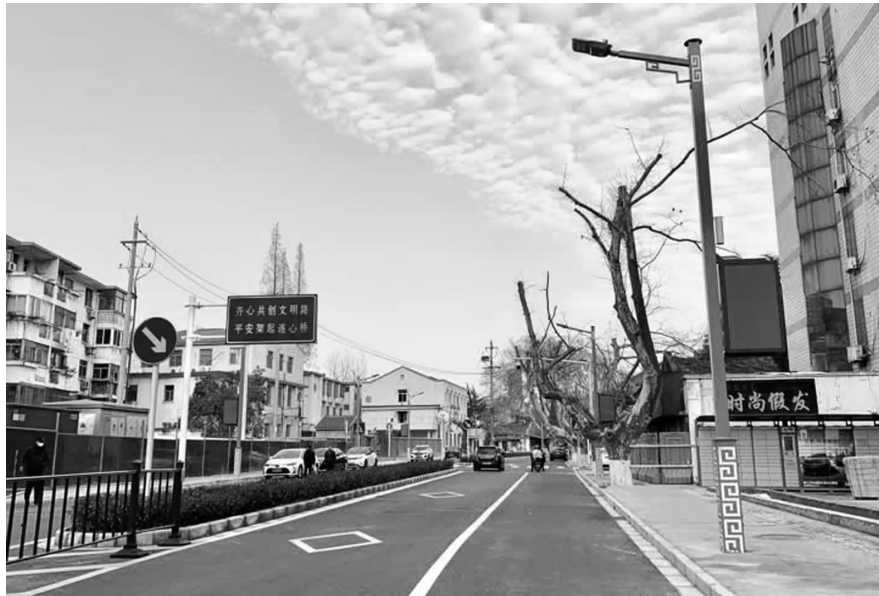
新马路附近装上的智慧路灯 通讯员供图
