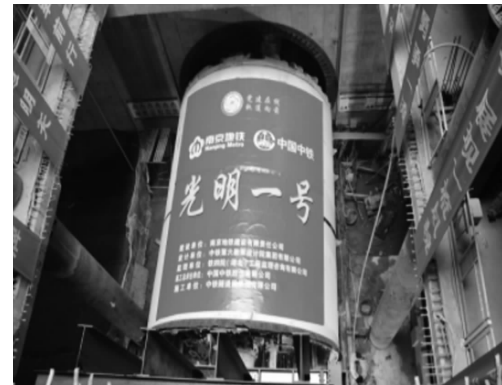
地铁6号线光华门站-明故宫站右线盾构始发 南京地铁供图
