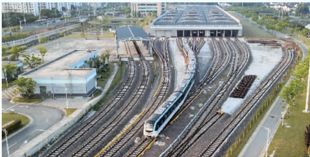
3号线列车 本版图片均由无锡地铁提供
