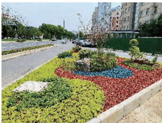
开展3号线沿线市政恢复
