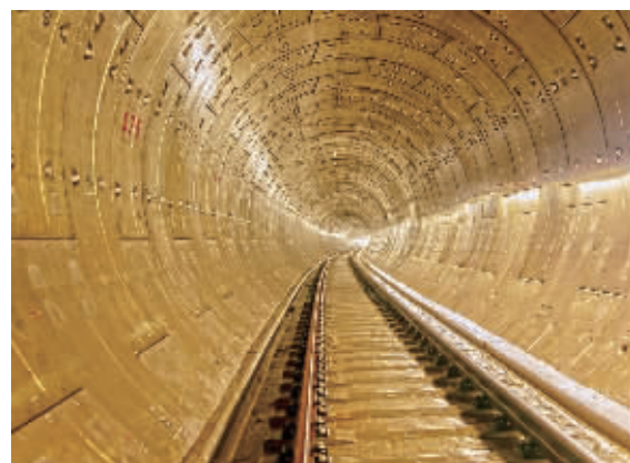
正在铺轨的隧道
