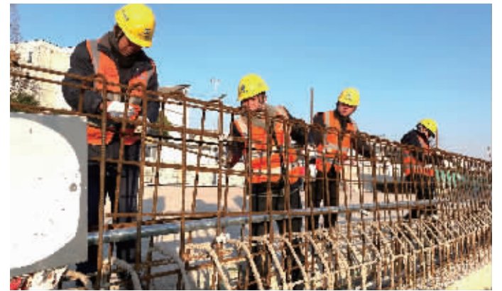
桐泾路北延工程项目现场
