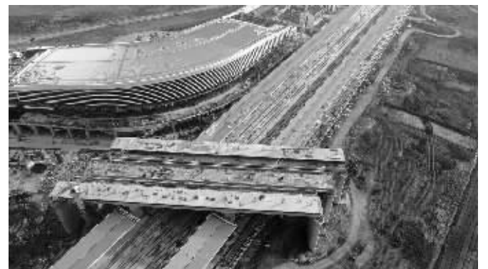
连镇铁路南延上跨南沿江铁路同步实施工程全部完成 王海摄
