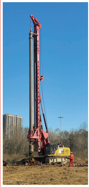
宁芜铁路扩能改造工程施工现场 通讯员供图
