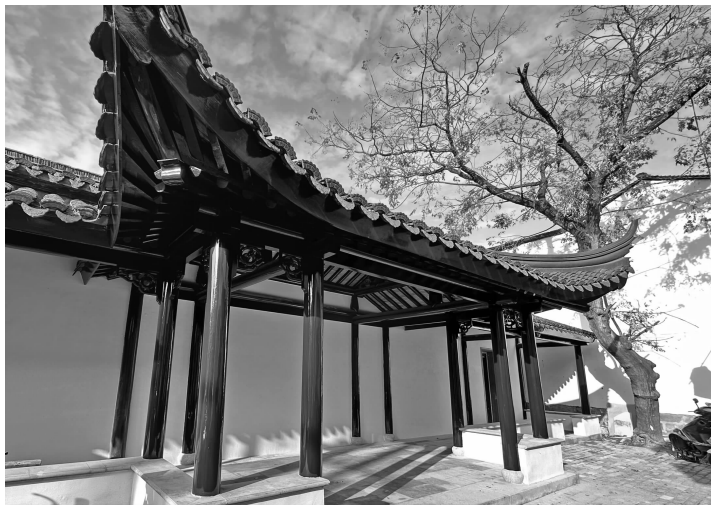
新建的凉亭 金阊街道供图
