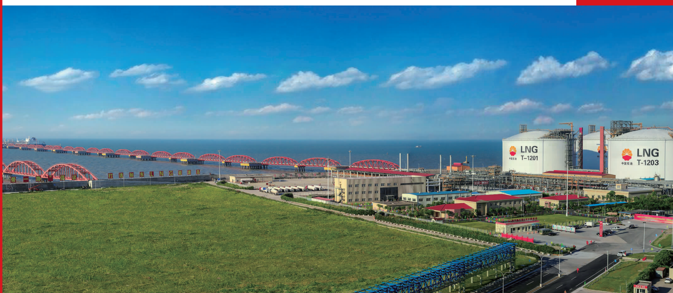
洋口港LNG接收站 洋口港经济开发区供图
