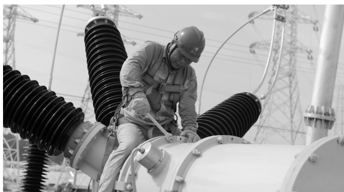
一名工人在施工 通讯员供图
