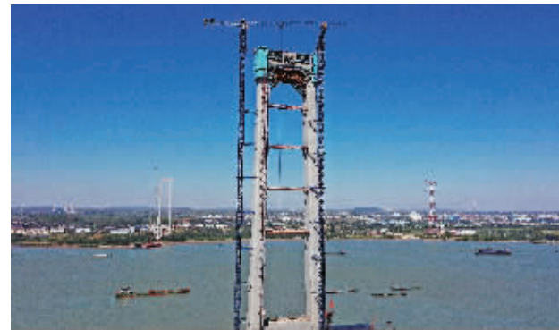
龙潭长江大桥南主塔“龙珠”混凝土施工完成 通讯员供图
