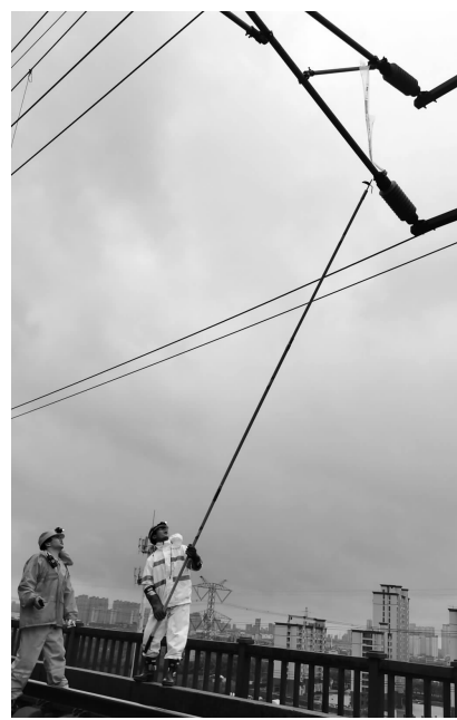
“梅花”北移减弱后，长三角铁路停运列车陆续恢复运行。图为上海高铁基础设施段清理高铁线路接触网上的异物 李波 摄
