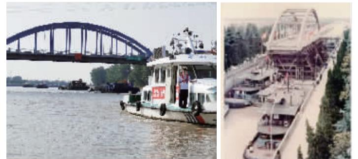
宝应运河大桥即将拆除 现代快报+记者 韩秋 摄 原大桥系杆拱整体搬运 资料图
