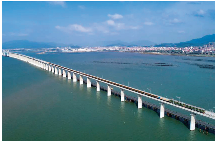
2022年4月15日拍摄的建设中的新建福厦铁路湄洲湾跨海大桥(无人机照片) 新华社发
