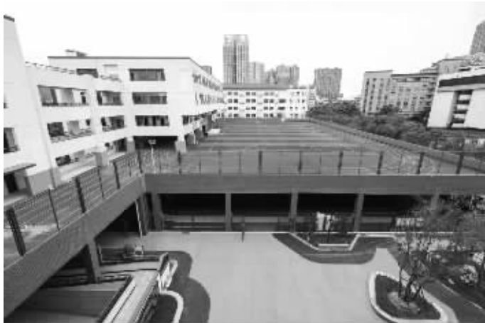
地下室局部夹层和二层为立体运动场 学校供图
