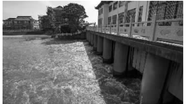
南京市高淳区蛇山抽水站出水 高淳融媒体中心供图
