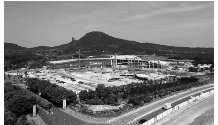
工程施工现状 图片来源:江宁发布
