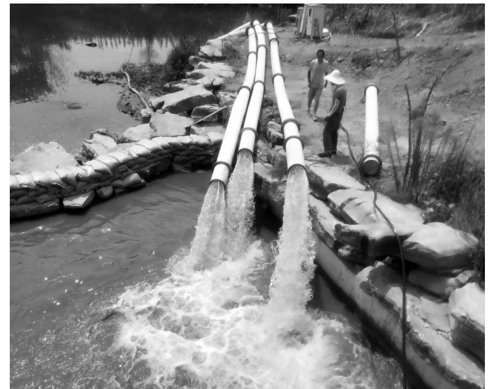
多台抽水泵启动为水稻田送水 通讯员供图
