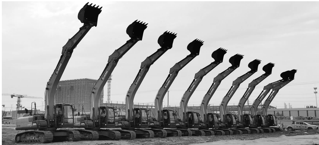
开工活动现场 通讯员供图
