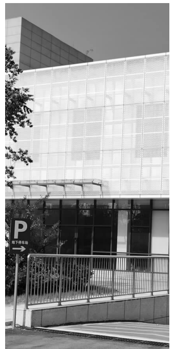
江宁区竹山路换乘中心已完工 现代快报+记者 赵丹丹 摄
