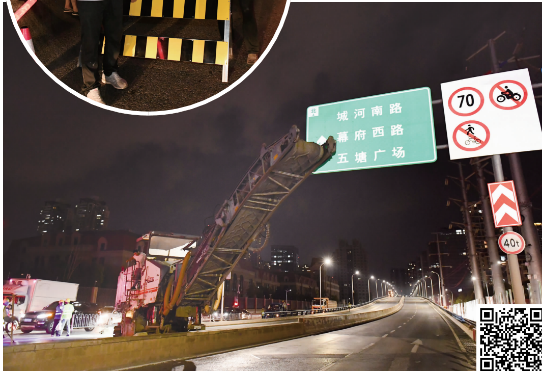
封闭施工现场 扫码看视频
