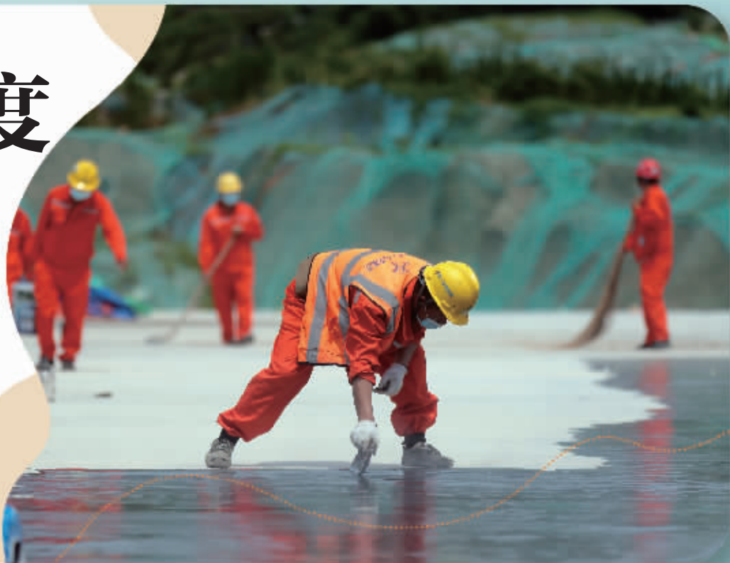
7月13日，南京马家店隧道施工现场，工人冒着炎热施工 现代快报+记者 顾炜 摄
