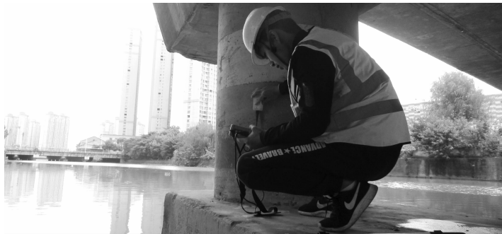
桥梁检查 锡山城管供图
