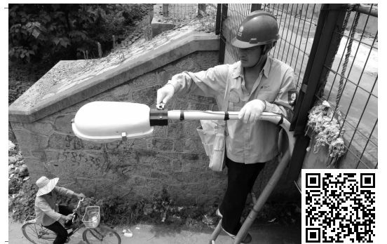
老权在更换涵洞路灯 邵迎进 摄 扫码看视频
