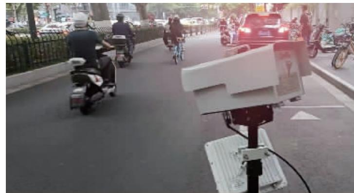
交警在路口放置移动式电动自行车违法缉查布控仪
