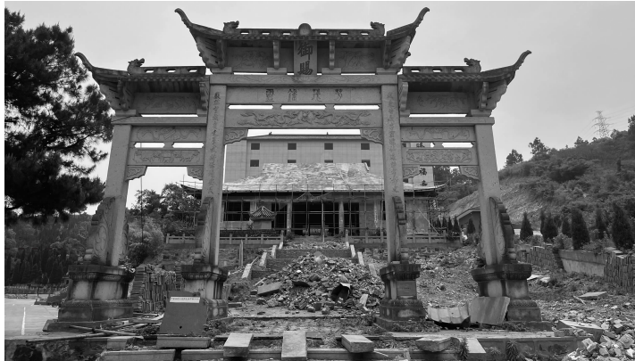
►纪念馆修复施工现场
