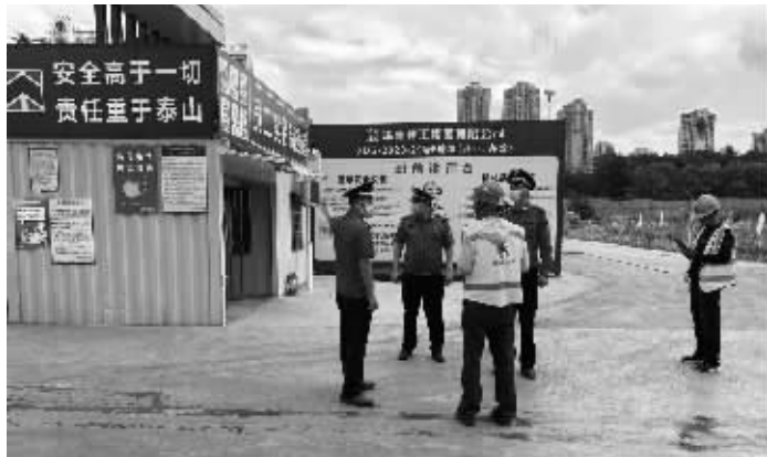
执法人员提醒在建工地中高考期间实行“禁噪令” 滨湖城管供图
