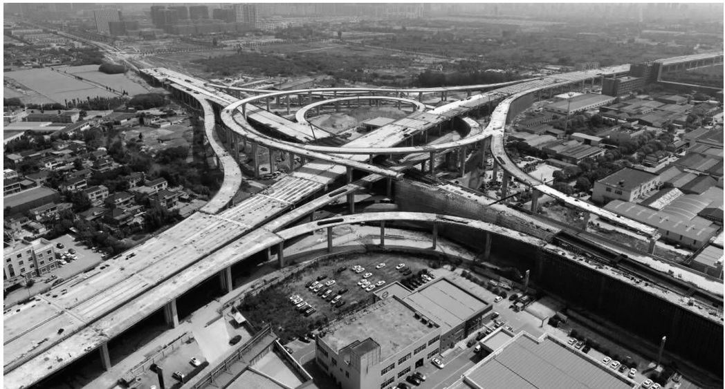
姜堰南绕城(盐靖高速至新229省道段)快速化改造工程项目是泰州重点民生工程,暂定项目总投资26.16亿元。目前,该项目建设重点已由下部结构施工全面转为上部桥梁施工,预计省运会前可实现姜堰上海路往泰州方向高架主干道的贯通。图为溱湖大道互通已经基本成型。 单莉茹 毛晓华 摄影报道
