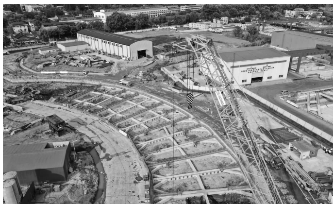
建宁西路过江通道建设突破新节点 通讯员供图
