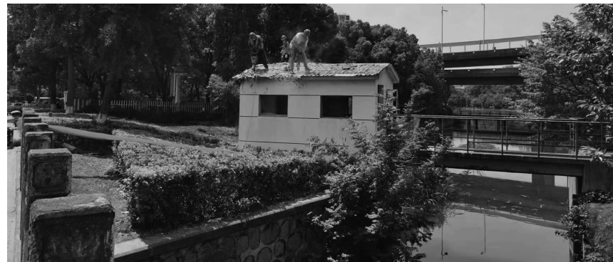
拆除现场 白洋湾街道供图
