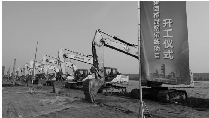
中天钢铁集团精品钢帘线项目开工现场 通讯员供图
