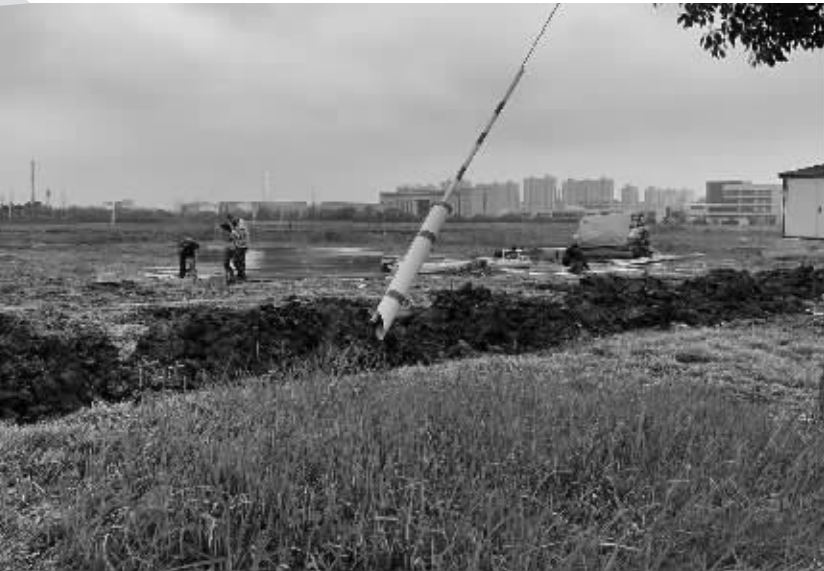
项目仅用了不到一个月时间就办出了施工许可证,实现“拿地即开工” 通讯员供图
